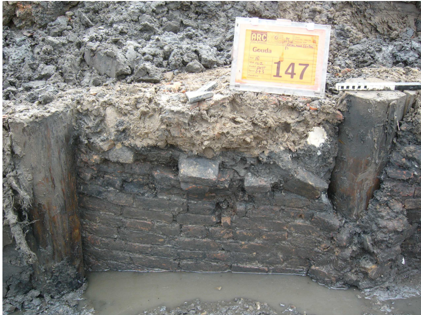
2C: Houten paal die door een muur heen is geheid, aangetroffen bij opgravingen op de Koningshof in Gouda. Uit Groenendijk (2009), foto gemeente Gouda.
