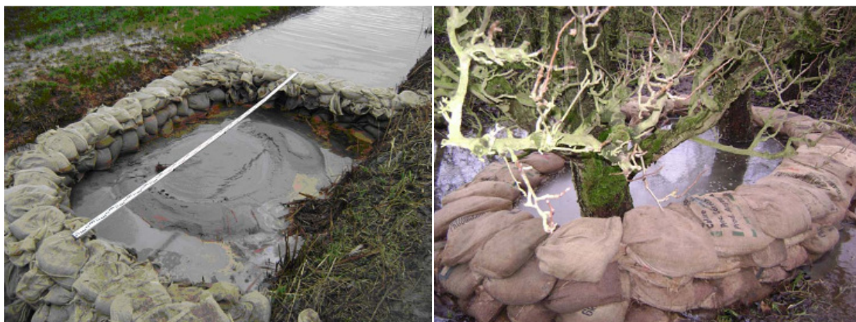
Figuur 3: Foto's van de zandmeevoerende wellen bij dijkpaal RW065 (Niemeijer, 2011)
